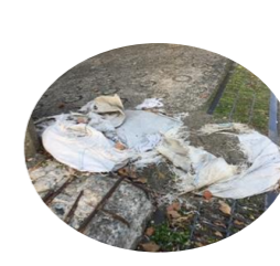
劣化した駐車場の土壌
